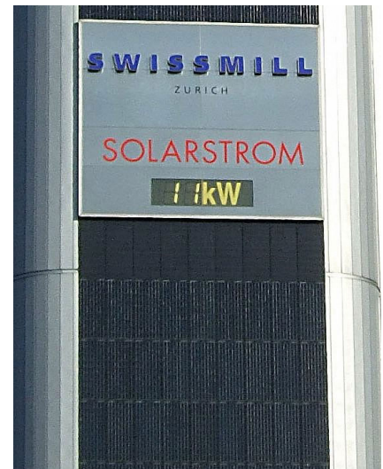
Abb 2 Photovoltaik-Anlage in Zürich: Energie aus erneuerbarer, CO 2 -Emissions freier Quelle
